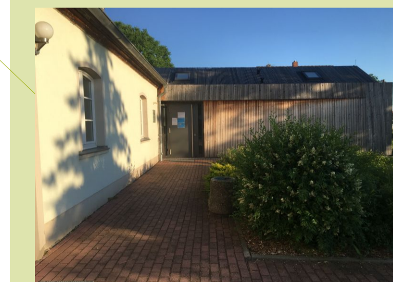
Der Zugang zum Anbau /Ortsteilzentrum ist gepflastert und auch barrierefrei erreichbar.
