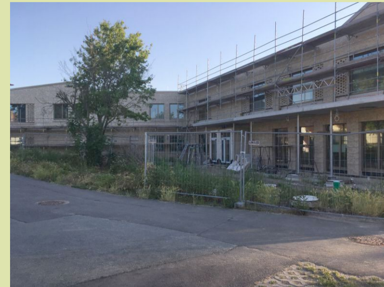
Schulbaustelle, z.T. Entwässerungsanlagen in der Grünfläche, Einbindung der Flächen in die Platzgestaltung
