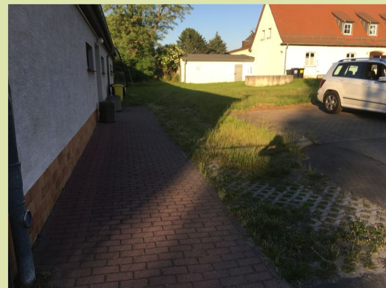
Der Zugang zu den Umkleiden der Turnhalle ist befestigt. Mülltonnen stehen im Sichtbereich des Platzes.
