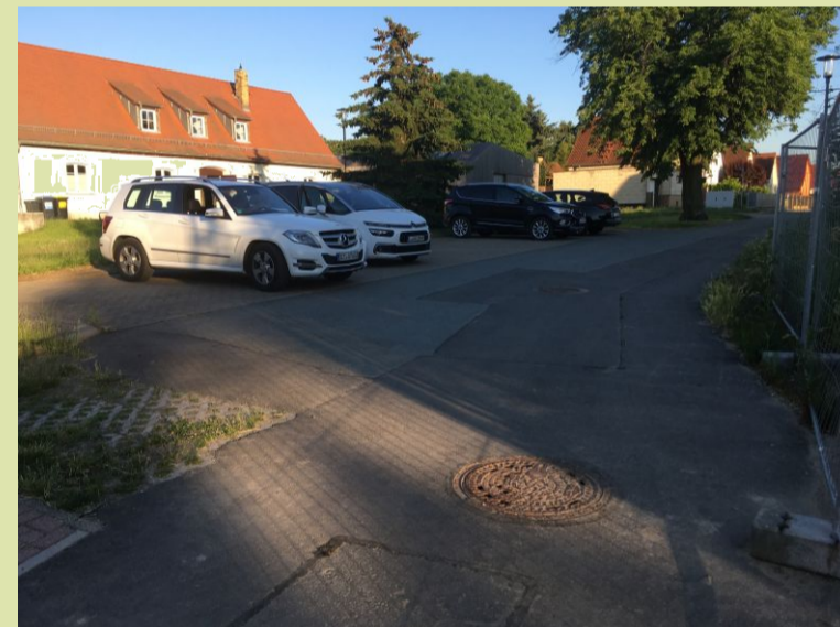
Die Asphaltstraße ist in schlechtem Zustand, der PKW-Parkplatz dominiert die Freiflächen
